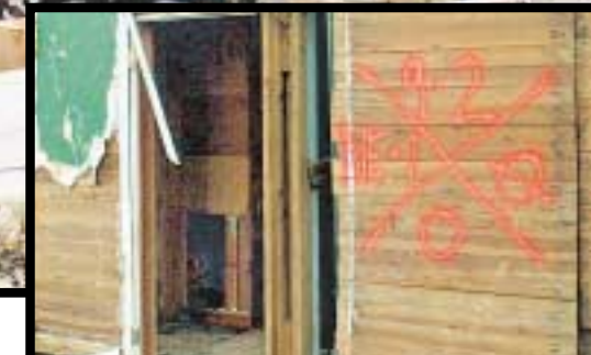
ZEICHENSPRACHE Rettungskräfte durchsuchen die Häuser nach Opfern, kennzeichnen sie mit einem X (kleines Foto): Dazu kommt oben das Datum, unten die Zahl der Toten (in diesem Haus starb niemand), links die Zahl der Überlebenden und rechts das Zeichen der Rettungseinheit. An einem anderen Haus in Biloxi schreibt ein Feuerwehrmann „Gas“ – das bedeutet: Vorsicht, hier liegt eine Gasleitung
